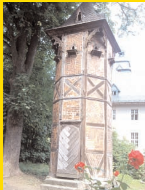
Taubenturm, um 1700 als Fachwerkbau mit Ziegelausmauerung errichtet
